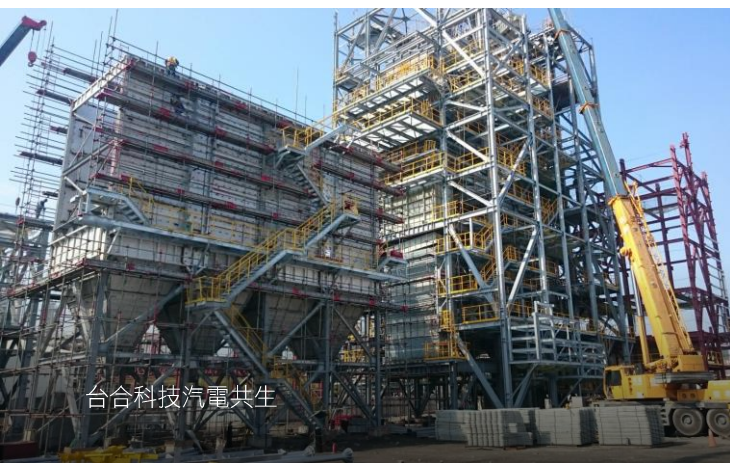
林口電廠改善工程-筒式煤倉系統
